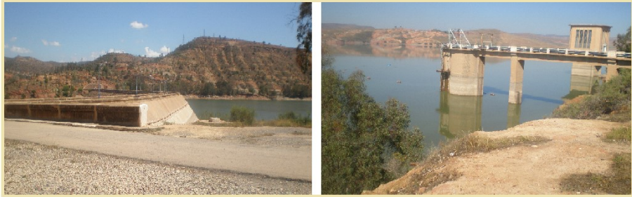
Photos 2 : Vue générale du barrage Algérien de Bouhanifia (Photos. A. Ouadja, H. Benfetta, 23 /06/2011).
