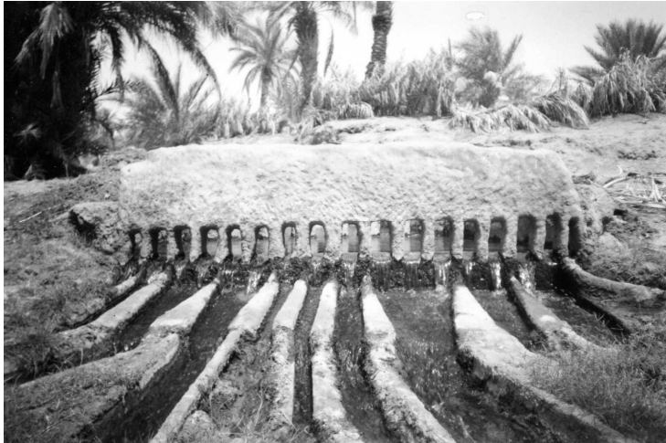
Photographie 3 : Kasria secondaire de la Foggara d'EL Meghier Timimoune ( Remini, 2000 )
