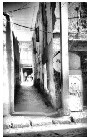
Poteau électrique encombrant la circulation piétonne.
